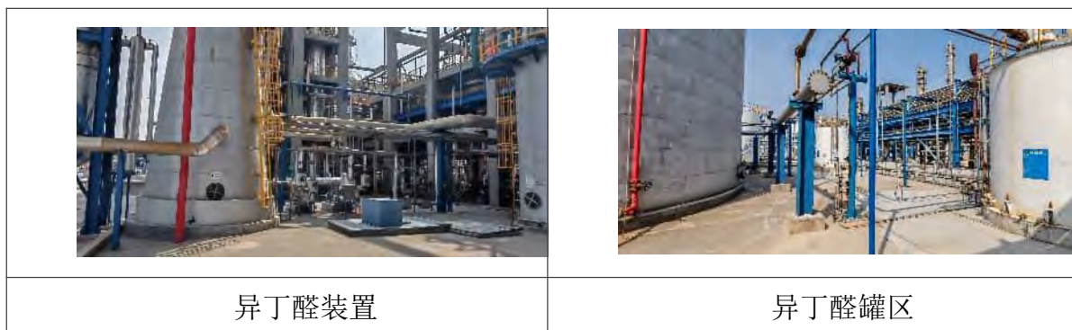
图 3.6-1 项目建设现状图
