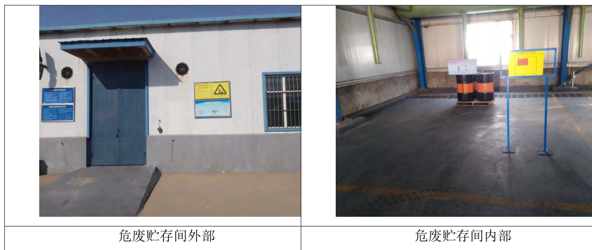
图 4.1-3 危险废物收集设施
