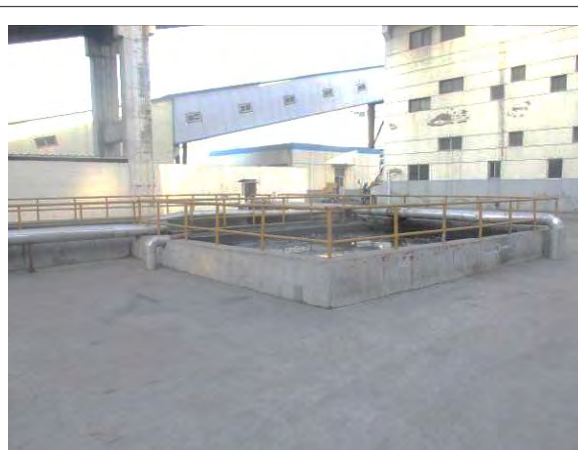
含煤废水沉淀池
