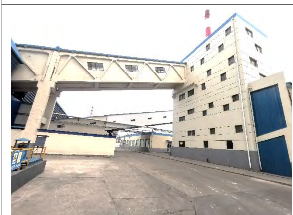
封闭式输煤廊
