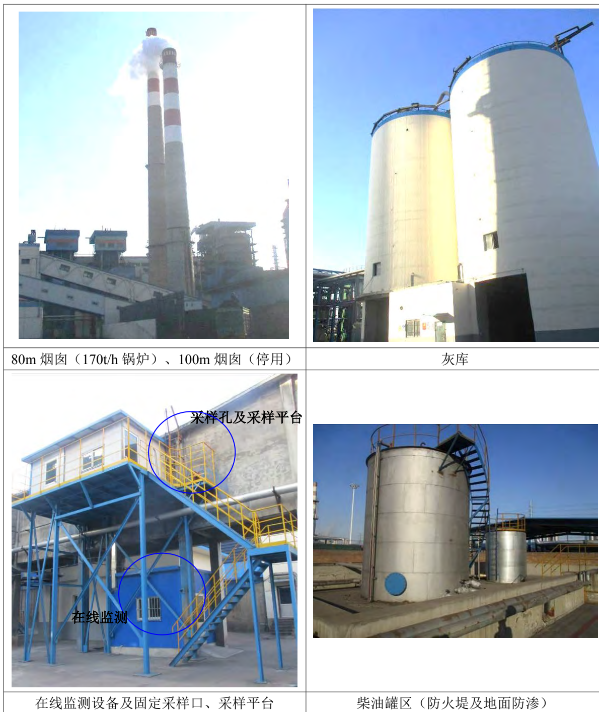
图 3.5-1 项目建设现状图
